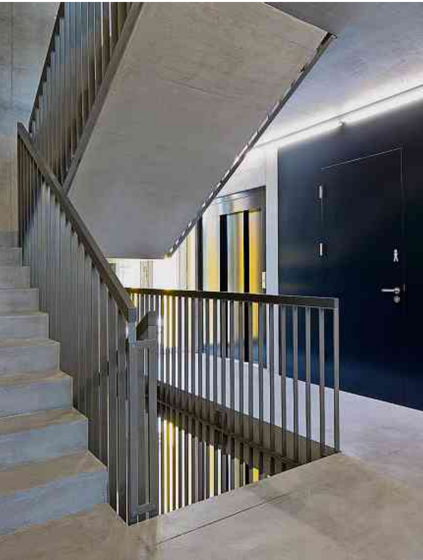
Das Bürogebäude wurde hauptsächlich aus Sichtbeton erstellt.
