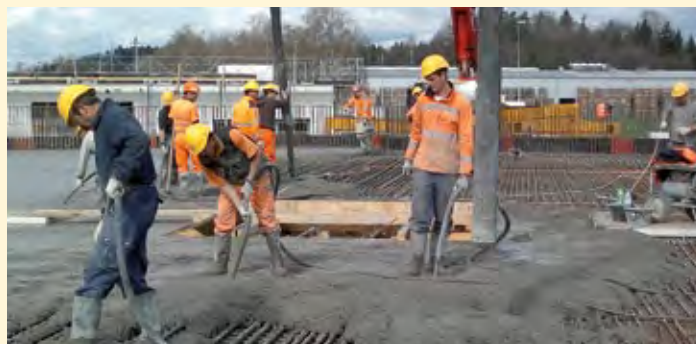
Betonierequipe für die Bodenplatte Zuckersilo 6
