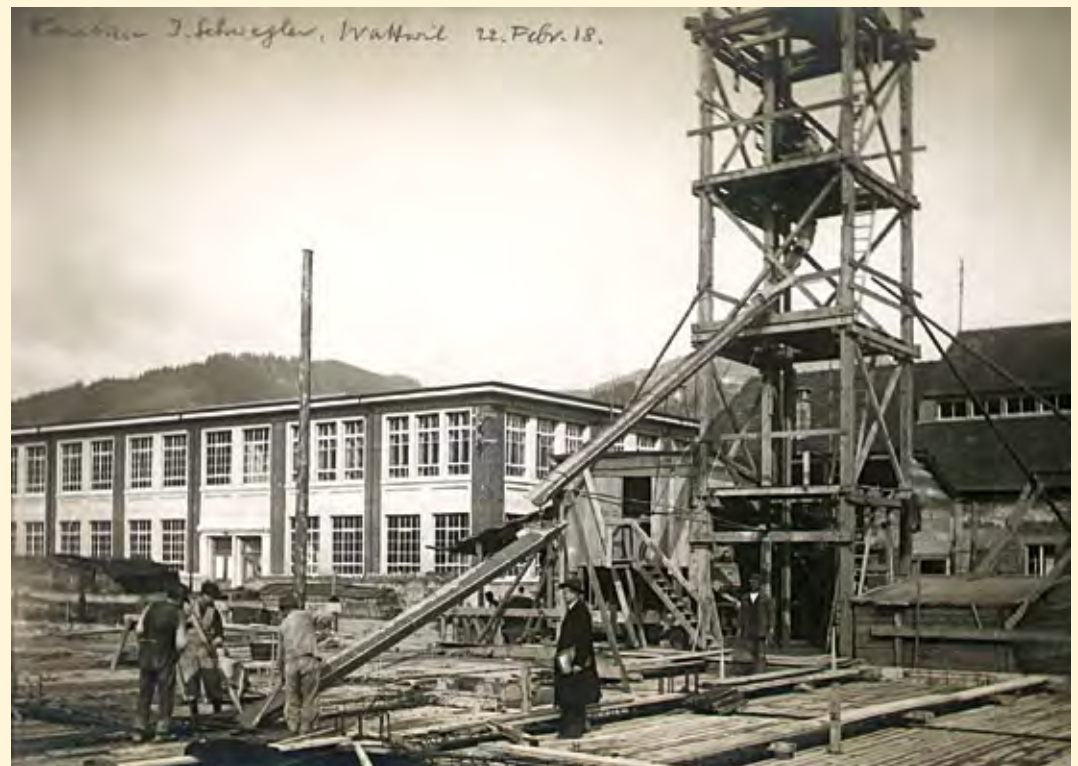
1918: Neubau J. Schwegler, Wattwil. Mit Turmkonstruktion für Betonmischer und Betonverteilung.
