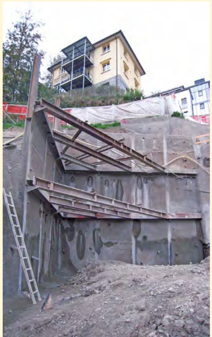
Heiden, MFH Paradiesweg Baugrubensicherung: 10 m hohe Rühlwand mit Eckversperrung
