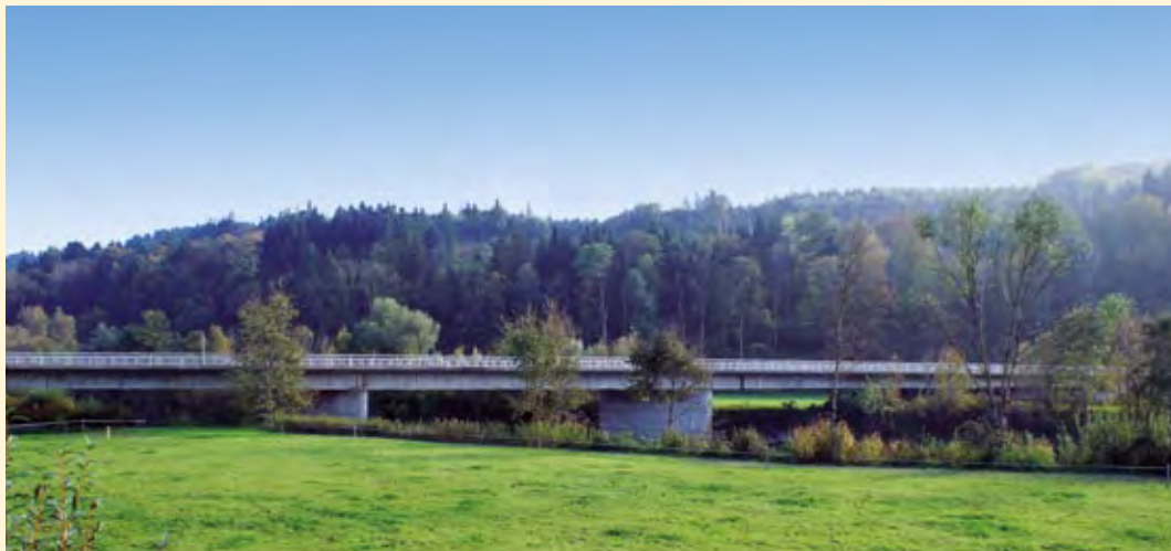
Die 150 m lange Eschikofer Brücke, die erste Brücke in der Schweiz, die 1954 in Vorspanntechnik gebaut wurde.
