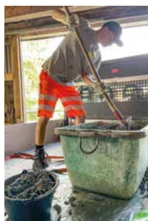
Mistkanal anbetonieren
