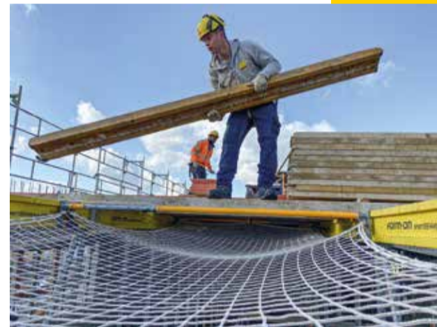
7. Die Absturzkante ist gesichert, alle weiteren Arbeiten dürfen auf der Schalung ausgeführt werden.
