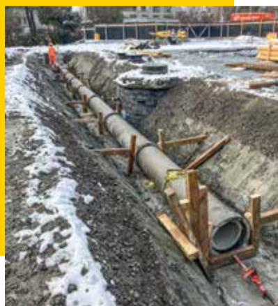
Bauherr McDonald's Schweiz AG, Crissier Bauingenieur/Planer Wälli AG, Ingenieure, Arbon Architekt Mint Architecture AG, Zürich
