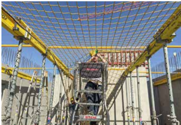
5. Die Arbeiten können von einer Podestleiter aus ausgeführt werden.
