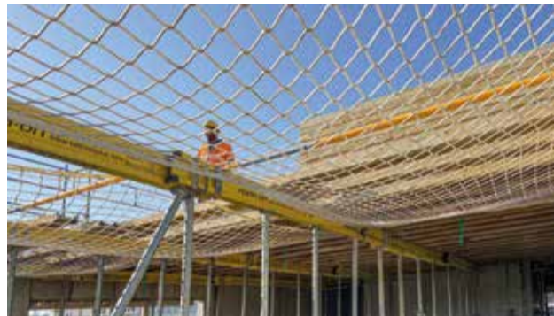
6. Das Netz ist fertig eingebaut.
