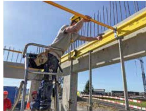
3. Die Querstangen werden am Sattelträger eingehängt und befestigt.
