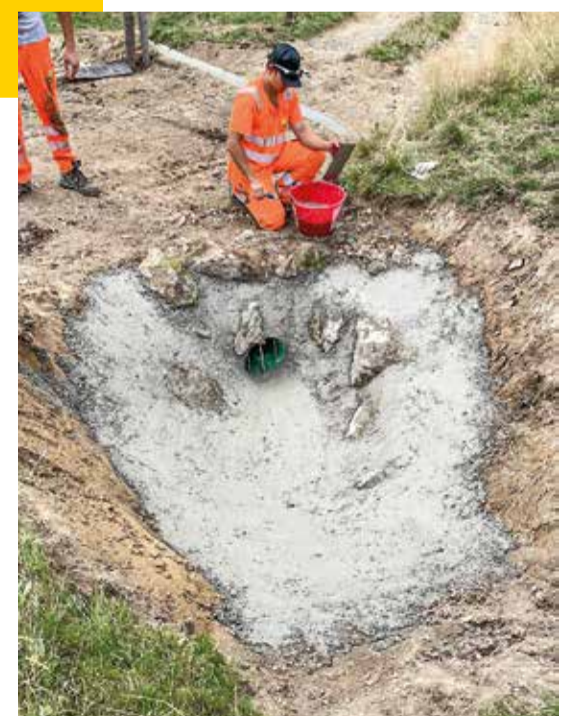
Wasserdurchlass unter Alpweg
