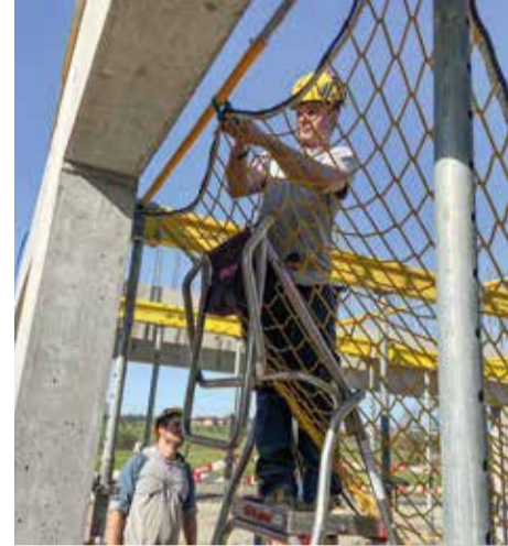
4. Die Netze werden an den Querstangen befestigt.
