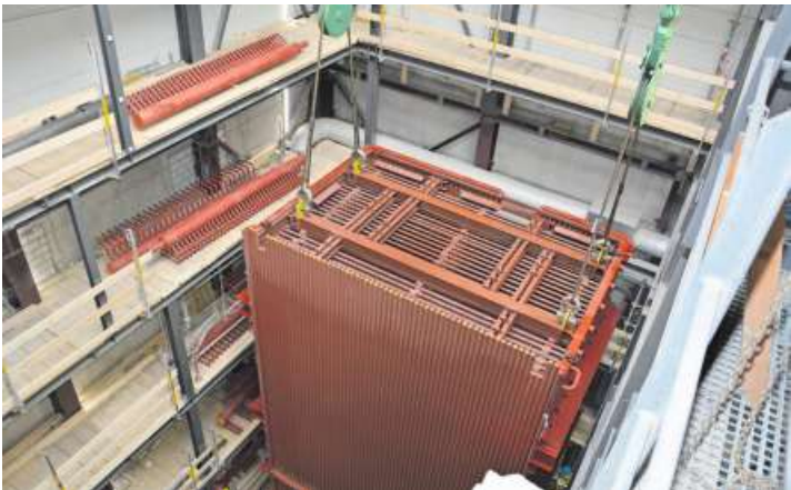
Das erste von vier Teilen des neuen Dampfkessels erreicht gleich seinen Bestimmungsort. Bilder: Beat Lanzendorfer
